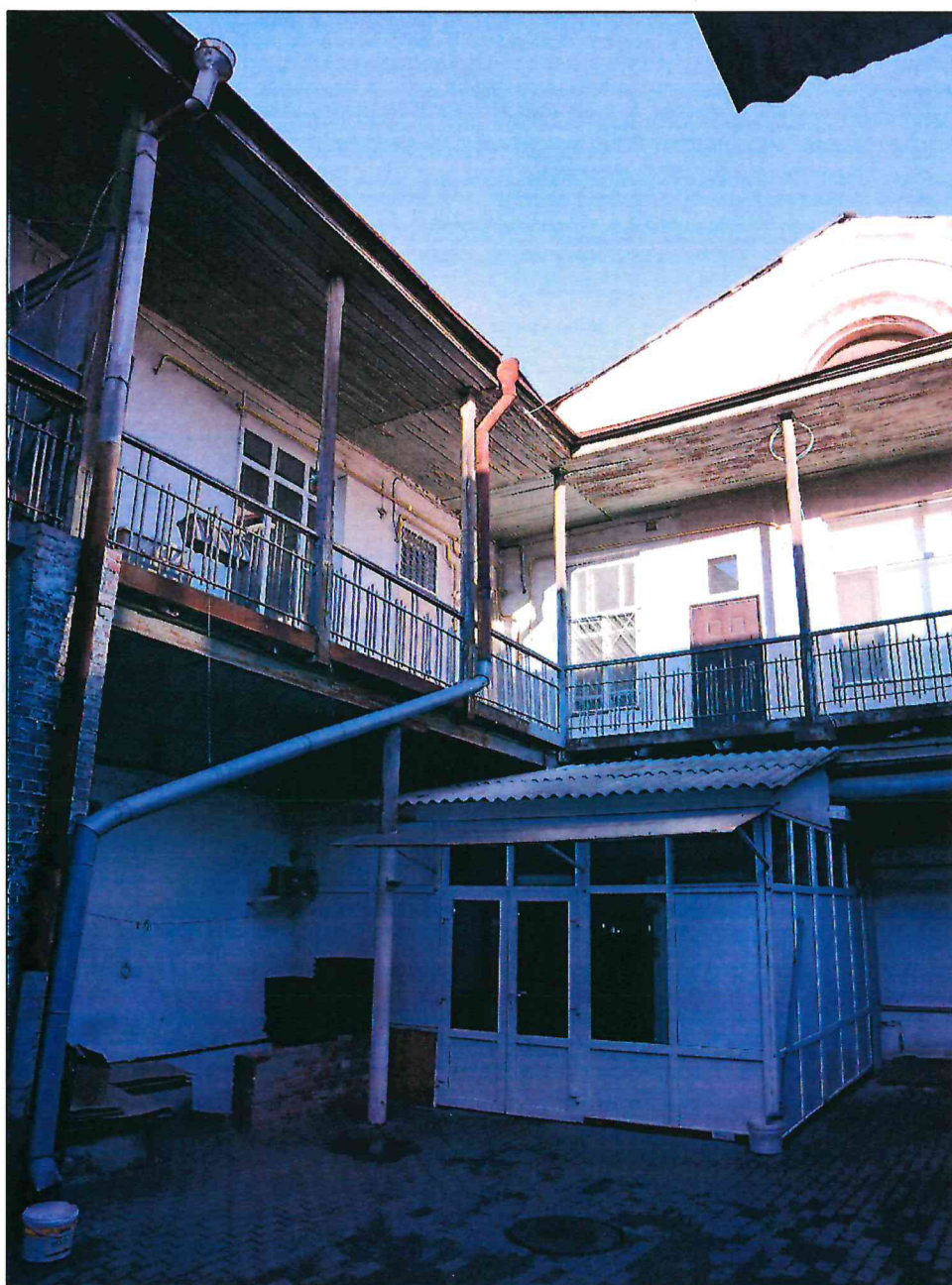
10. Дворовые фасады Объекта. Вид с юго-запада.
