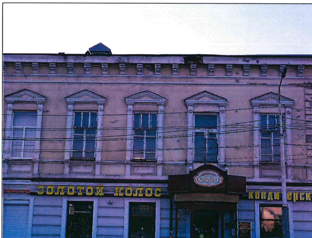
5. Фрагмент парадного восточного фасада в уровне второго этажа. Фото 2024 года.
