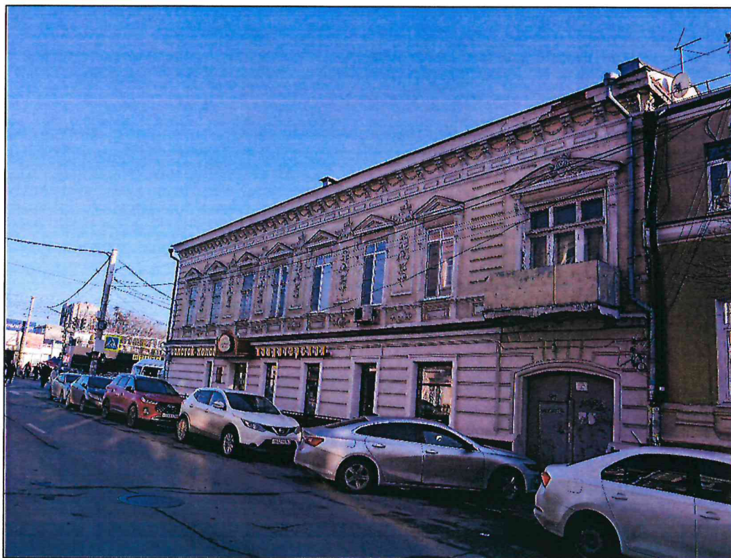
3. Парадный северный фасад Объекта. Фото 2024 года.
